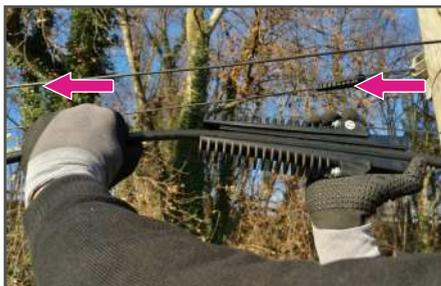
Pousser les clavettes vers l'avant tout en tirant sur le câble côté portée pour verrouiller le câble dans la pince d'ancrage.
