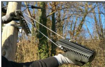
Installer l'ACADSS sur la ferrure d'ancrage. Veiller à la bonne installation de la cosse.
