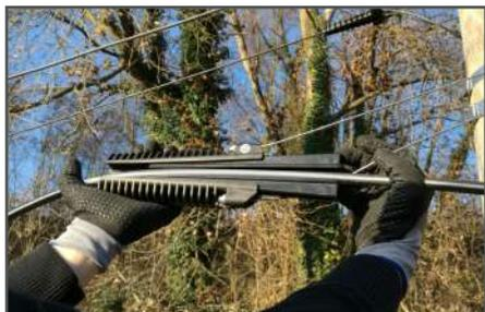
Laisser une surlongueur de câble entre les deux pinces d'ancrage. Maintenir l'anse de l'ACADSS en tension et installer le câble entre les coins à la tension voulue.
