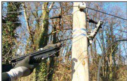
Installer l'ACADSS sur la ferrure d'ancrage dans l'alignement de la pince d'ancrage précédemment installée.
